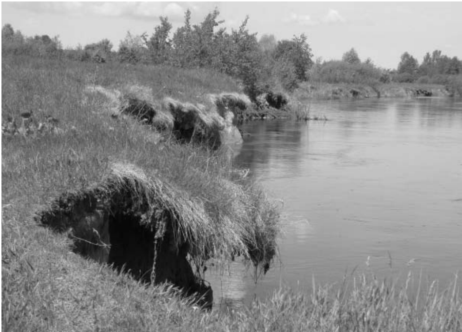
Fot. X-1. Bug w okolicach Zbereża – brzegi rzeki podmywane przez wody korytowe (fot. H. Wójciak, 2008)
