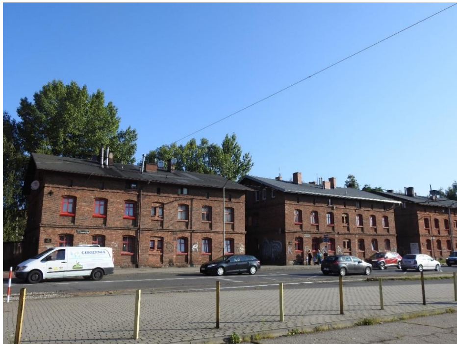
Osiedle robotnicze w Rudzie Śląskiej przy ul. Niedurnego (Fot.: A. Hutniczak).
