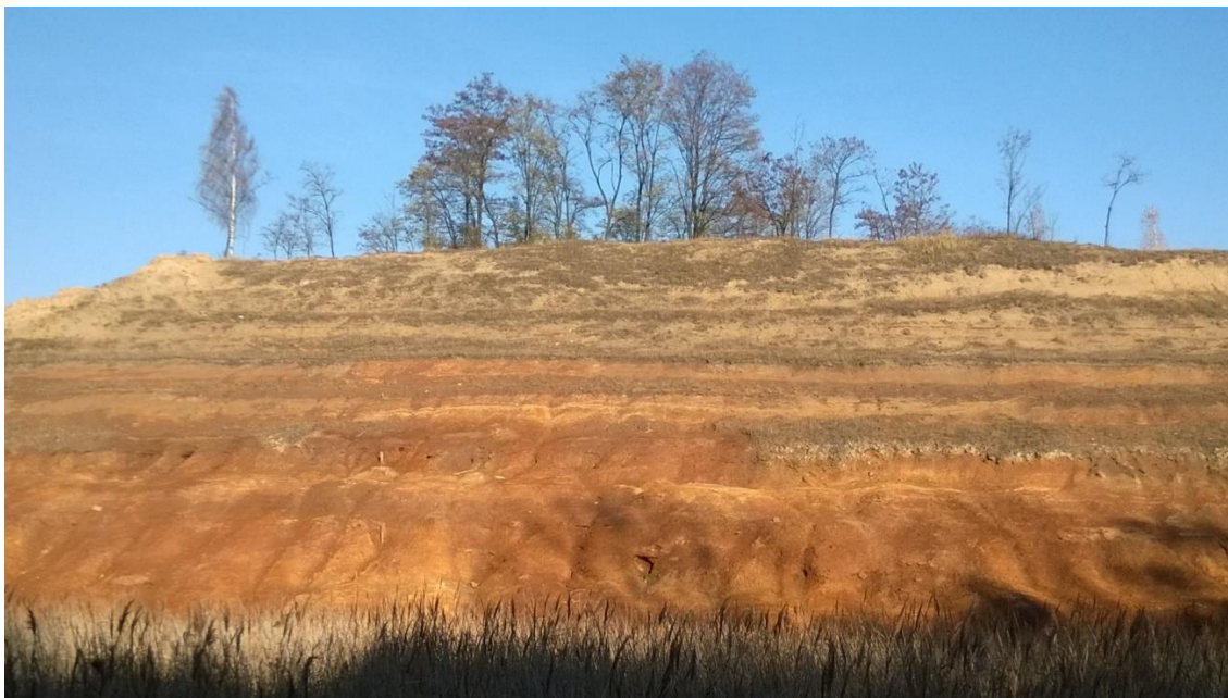
Osadnik odpadów połotacyjnych ZGH „Orzeł Biały” na obrzeżach „Żabich Dołów” (Fot.: M. Jędrzejczyk-Korycińska).
