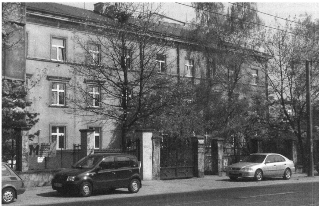
Ryc. 6. Instytut Botaniki PAN przed rozbudową i przebudową (2001 r.).
