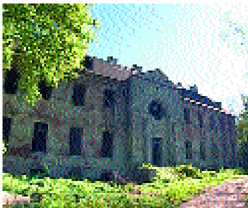
Fot. 3. Ruiny pałacu z 2004 r. (zdjęcie archiwalne) Fig. 3. Ruins of the palace, 2004. (archival photo)
