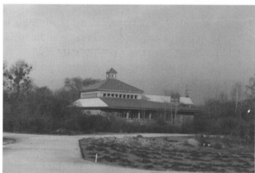
Ryc.2 Pawilon ekspozycyjno-dydaktyczny (w budowie) na terenie Ogrodu Botanicznego UAM w Poznaniu.
