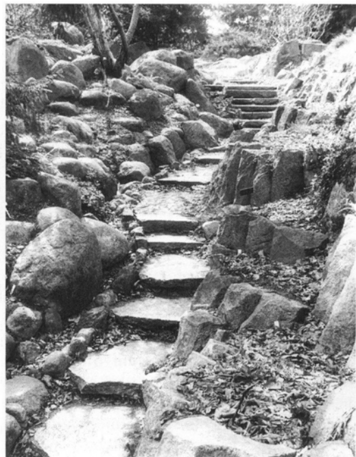
Ryc. 2 Pozytywny przykład zastosowania różnej wielkości głazów narzutowych (po lewej stronie) granitu łamanego, pochodzącego z usuwanych krawężników (po prawej stronie).
