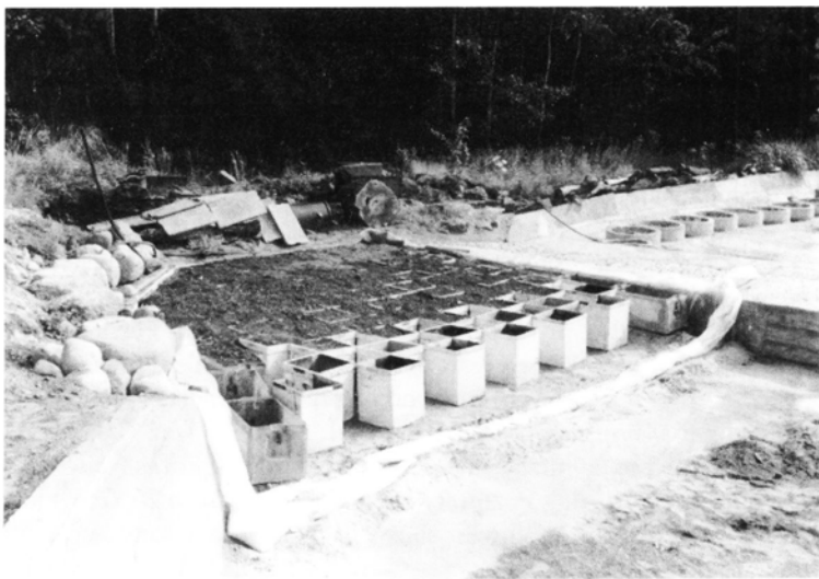
Ryc. 2 Pierwszy etap budowy niskich łąk zalewowych - widoczny wybetonowany wykop wyłożony folią i pojemniki plastikowe napełnione glebą dla roślin rozłogowych (fot. W. Potkańska)
